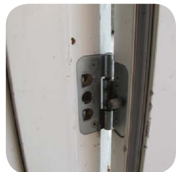
Udvendigt hængsel med nøkke
