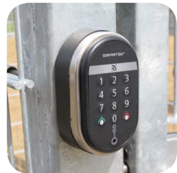
Onlinelæser monteret på gitterport
