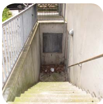
Kælderskakt kan bruges som skjulested
