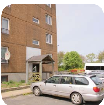
Beplantning ryddet, TV-overvågning og runderingsvagt
