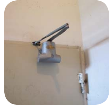
Dørpumpe der sørger for at døren lukkes automatisk
