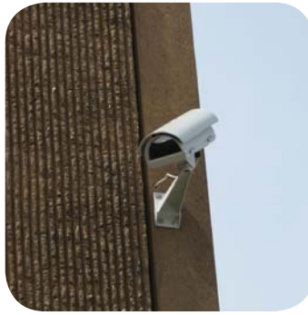
Videokamera monteret på arm
