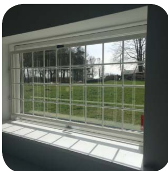
Gitter monteret på kældervindue.
