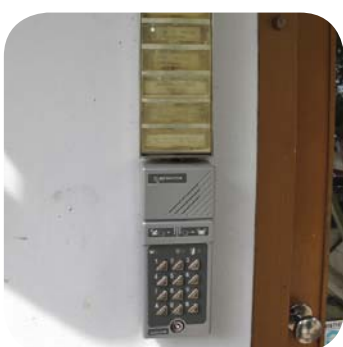
Kodetastatur for åbning af opgangsdøren
