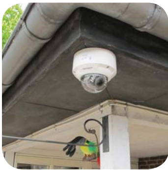
Lavt placerede kameraer skal være vandalsikrede
