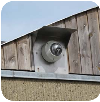
Et domekamera monteret på gavl
