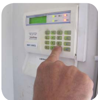
Betjeningspanel for indbrudsalarmsystemet
