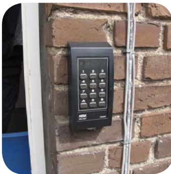
Onlinelæser med kodetastatur monteret udendørs
